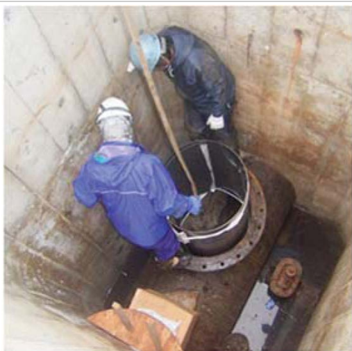
①SUS巻込み鋼板吊り込み
