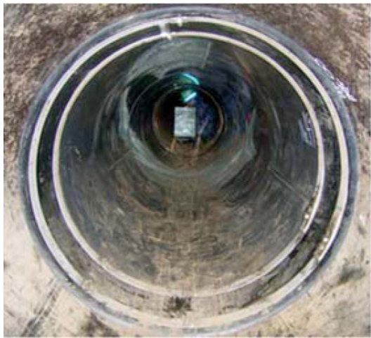
③止水バンド設置完成
