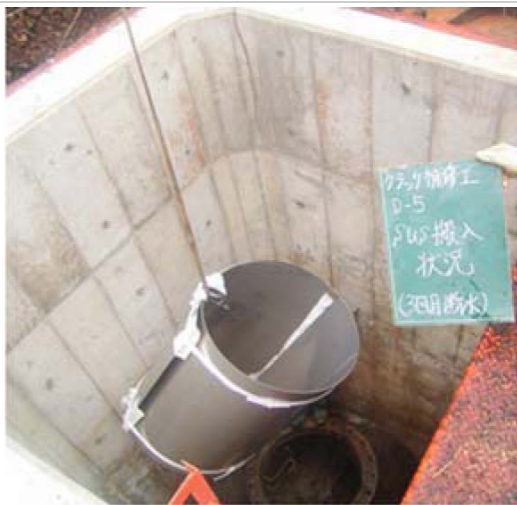
①SUS巻込み鋼板吊り込み
