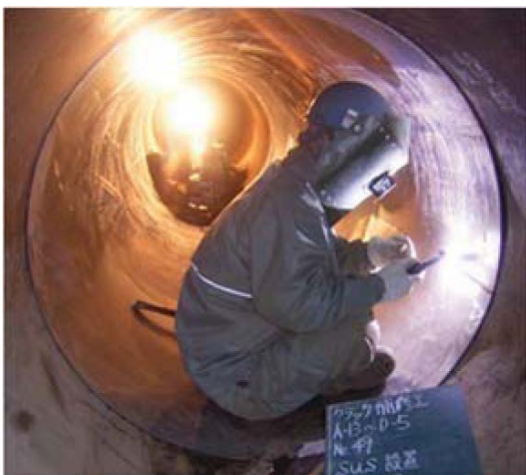
②鋼板拡径溶接
